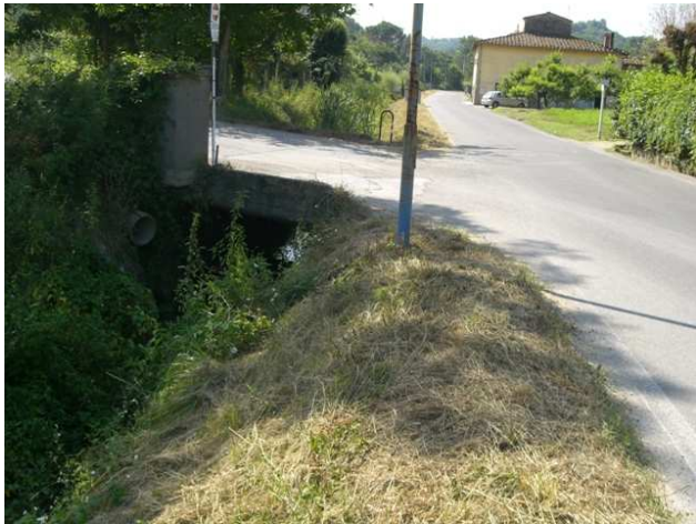
Foto 13.1: vista verso monte, tra le sezioni OR_PS_036 e OR_PS_037.
