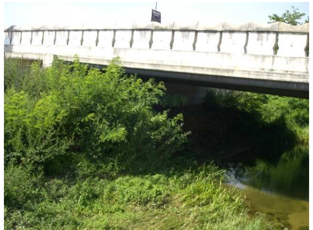
Foto 1.3: vista verso valle, sinistra idraulica, tra le sezioni GI_PS_013 e GI_PS_012. Note: Nuovo ponte.
