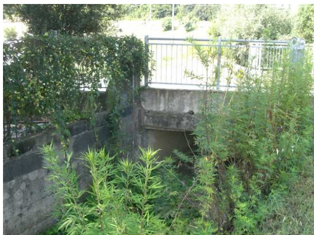
Foto 1.1: vista verso monte, tra le sezioni SP_PS_052 e SP_PS_055. Note: Ponte in VIA DELL'OSSAIA.
