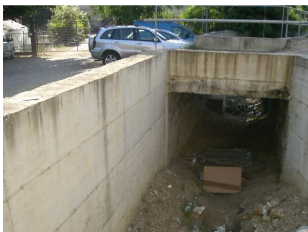
Foto 3.1: vista verso monte, tra le sezioni OR_PS_009 e OR_PS_008.
