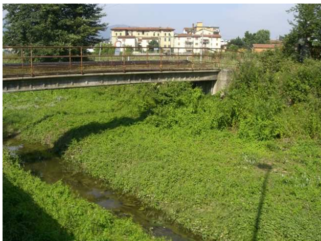
Foto 5.4: vista verso valle, sinistra idraulica, tra le sezioni GI_PS_044 e GI_PS_045. Note: Passerella pedonale.
