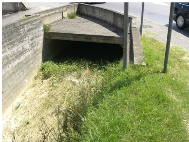
Foto 7.2: vista verso monte, tra le sezioni SP_PS_028 e SP_PS_027. Note: Ponte in VIALE LUIGI CADORNA.
