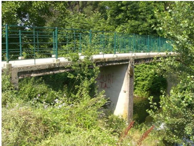
Foto 1.1: vista verso monte, tra le sezioni DO_PS_089 e DO_PS_090. Note: Passerella pedonale.
