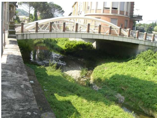
Foto 3.1: vista verso monte, tra le sezioni DO_PS_112 e DO_PS_111. Note: Ponte in VIA MARCONI.
