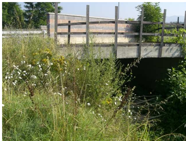
Foto 6.2: vista verso monte, tra le sezioni QU_PS_018 e QU_PS_017. Note: Ponte in VIA MADRE TERESA DI CALCUTTA.
