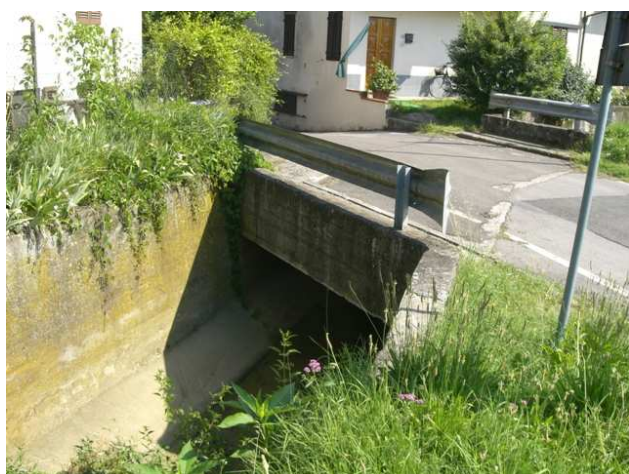
Foto 10.2: vista verso monte, tra le sezioni SP_PS_008 e SP_PS_009. Note: Ponte tra VIA CAVOUR e VIA GIUSEPPE VERDI.
