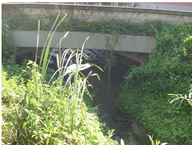
Foto 4.1: vista verso valle, tra le sezioni QU_PS_037 e QU_PS_036. Note: Ponte in VIA AMMIRAGLIO BURZAGLI
