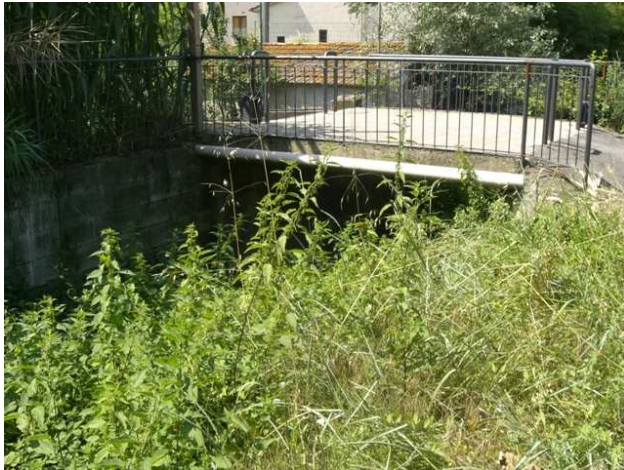
Foto 5.1: vista verso monte, tra le sezioni VL_PS_019 e VL_PS_020. Note: Passerella pedonale.
