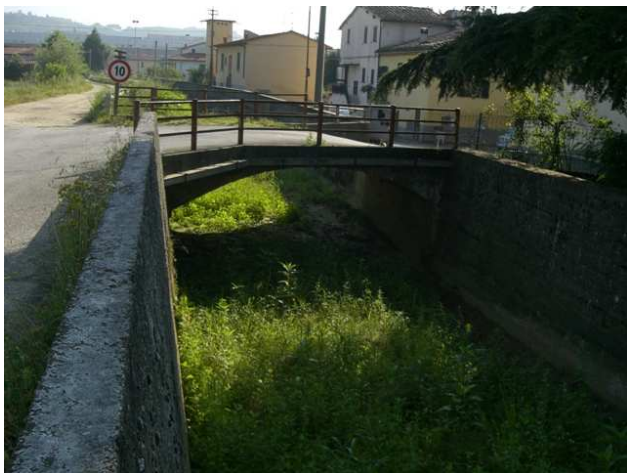
Foto 5.1: vista verso valle, tra le sezioni QU_PS_033 e QU_PS_032.
