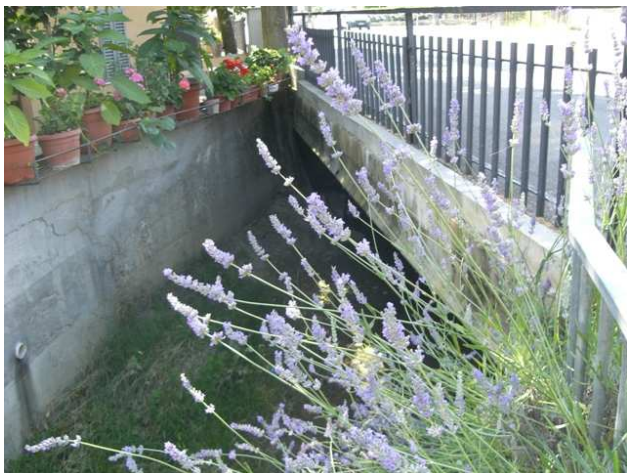
Foto 7.1: vista verso monte, tra le sezioni OR_PS_020 e OR_PS_021. Note: Ponte in VIA PACINOTTI.
