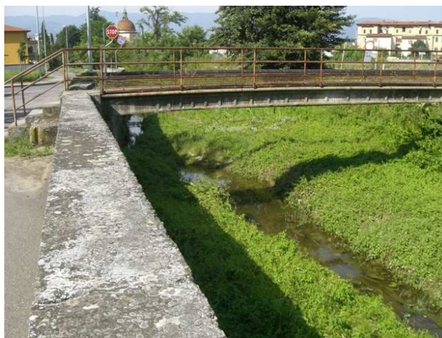
Foto 5.3: vista verso valle, sinistra idraulica, tra le sezioni GI_PS_044 e GI_PS_045. Note: Passerella pedonale.
