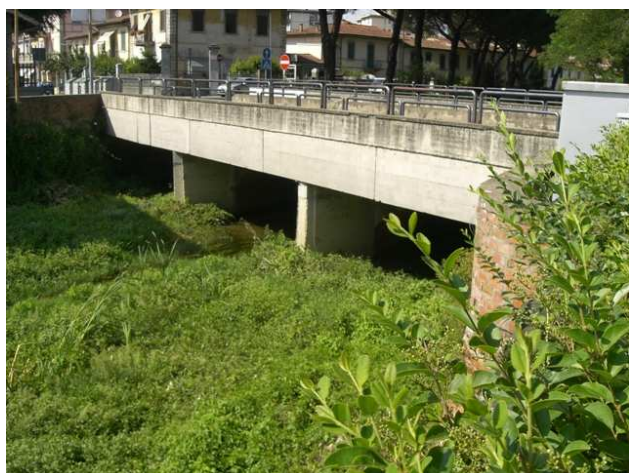
Foto 3.2: vista verso valle, tra le sezioni GI_PS_034 e GI_PS_035. Note: Ponte in VIA AMMIRAGLIO BURZAGLI.
