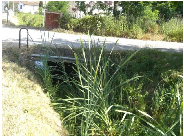
Foto 13.2: vista verso valle, tra le sezioni OR_PS_036 e OR_PS_037.
