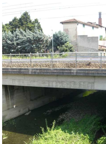
Foto 5.2: vista verso valle, tra le sezioni DO_PS_119 e DO_PS_120. Note: Ponte ferroviario FIRENZE-ROMA.
