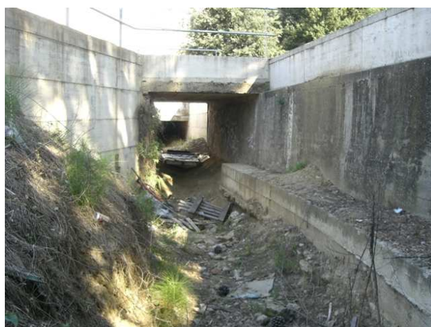
Foto 3.2: vista verso valle, tra le sezioni OR_PS_009 e OR_PS_008.
