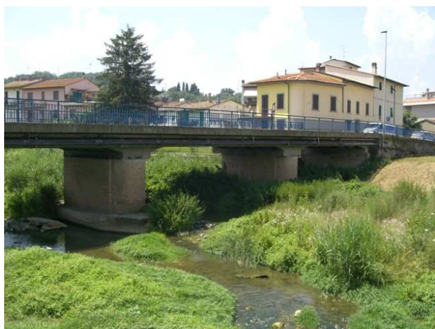
Foto 1.2: vista verso monte, alla sezione AM_PS_046 e la sezione AM_PS_047. Note: Ponte sulla S.S. 69 DI VAL D'ARNO.
