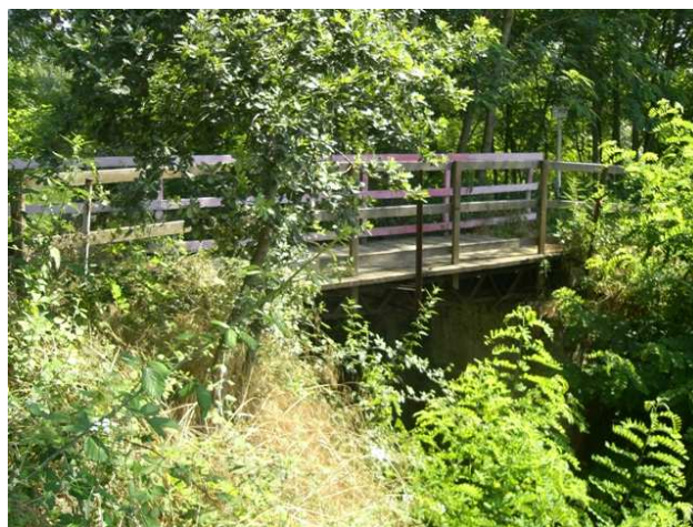
Foto 1.2: vista verso valle, tra le sezioni VL_PS_001 e VL_PS_002. Note: Passerella pedonale.
