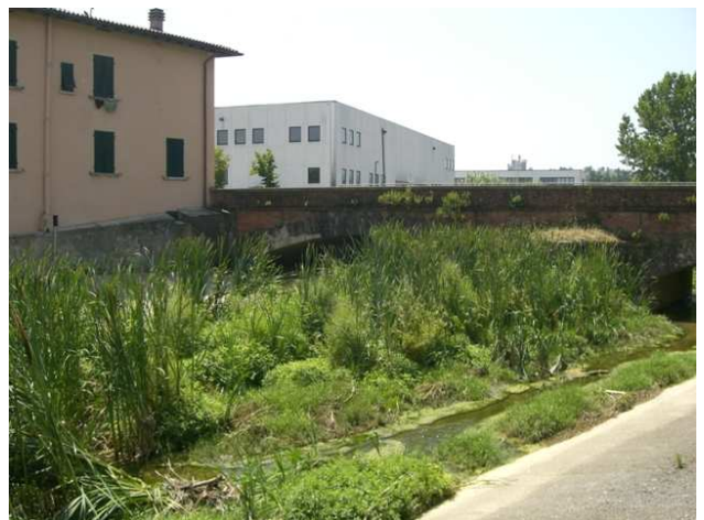
Foto 4.1: vista verso valle, destra idraulica, tra le sezioni CA_PS_13.9 e CA_PS_014.1. Note: Ponte sulla S.S. 69 DI VAL D'ARNO.
