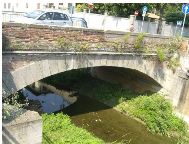
Foto 6.2: vista verso monte, tra le sezioni DO_PS_119 e DO_PS_124. Note: Ponte in VIA DELLE GINESTRE.
