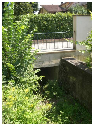
Foto 2.2: vista verso valle, tra le sezioni VL_PS_008 e VL_PS_009. Note: Ponte sotto giardino.
