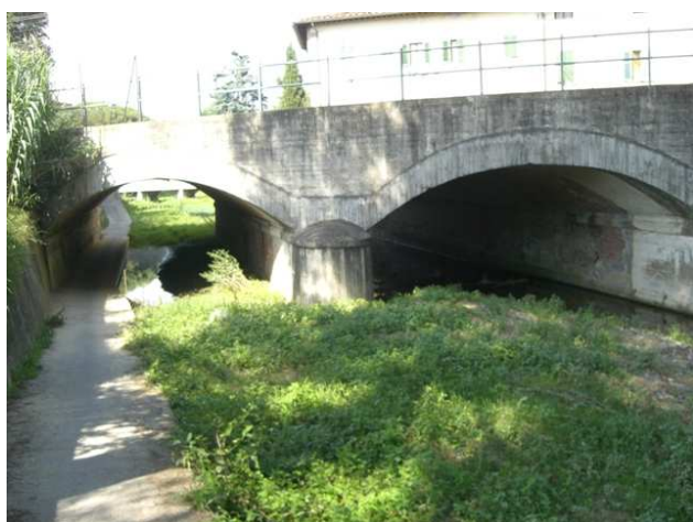
Foto 4.2: vista verso valle, tra le sezioni GI_PS_038 e GI_PS_039. Note: Ponte ferroviario FIRENZE-ROMA.
