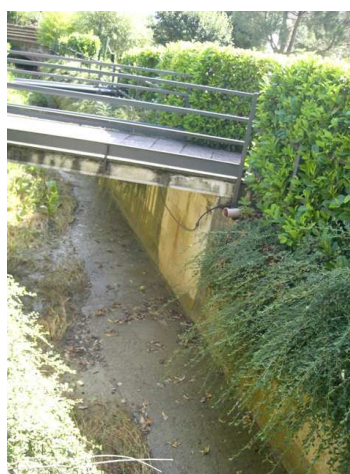
Foto 4.1: vista verso valle, alle sezione SP_PS_042. Note: Passerella pedonale.
