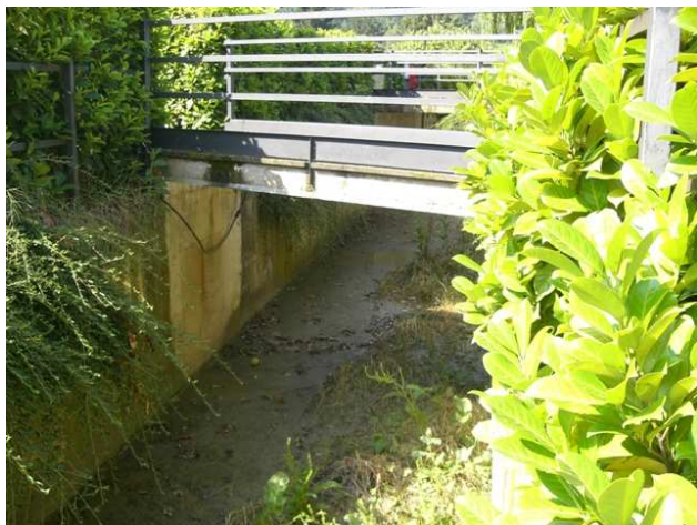
Foto 4.2: vista verso monte, alle sezione SP_PS_042. Note: Passerella pedonale.
