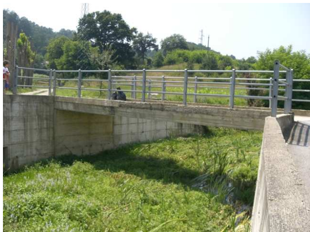
Foto 1.1: vista verso monte, alla sezione SA_PS_012. Note: Passerella pedonale.
