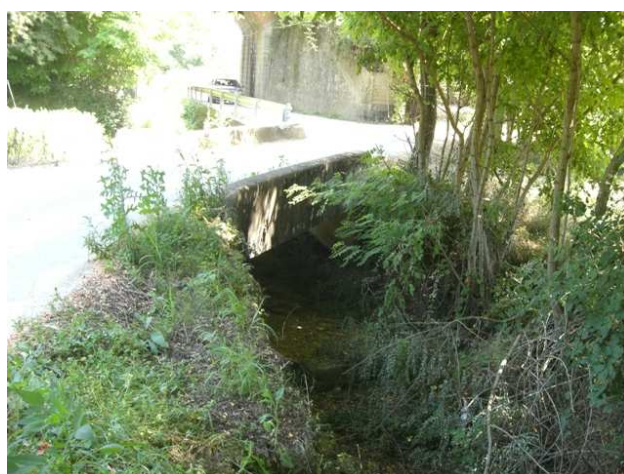
Foto 9.2: vista verso valle, tra le sezioni VL_PS_035 e VL_PS_036.
