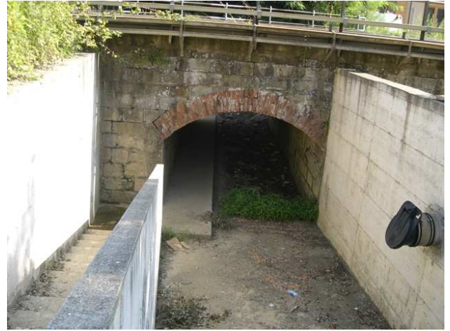
Foto 4.2: vista verso valle, tra le sezioni OR_PS_011 e OR_PS_010. Note: Ponte ferroviario FIRENZE-ROMA.
