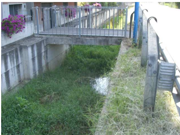
Foto 9.1: vista verso monte, tra le sezioni OR_PS_027 e OR_PS_028. Passerella pedonale.
