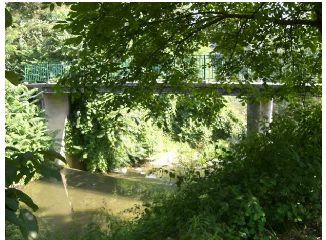
Foto 1.2: vista verso valle, tra le sezioni DO_PS_089 e DO_PS_090. Note: Passerella pedonale.
