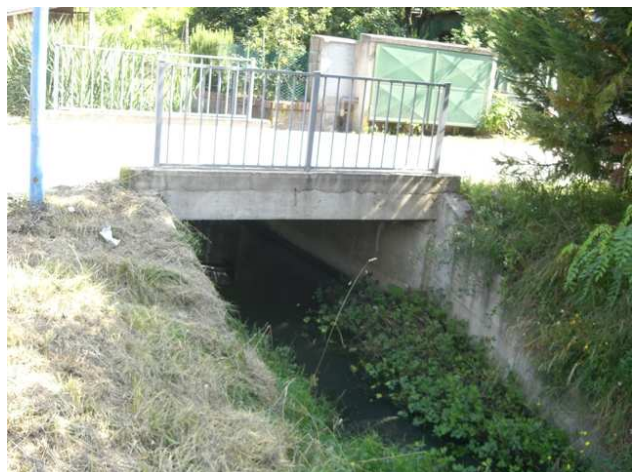
Foto 15.2: vista verso monte, tra le sezioni OR_PS_046 e OR_PS_047.
