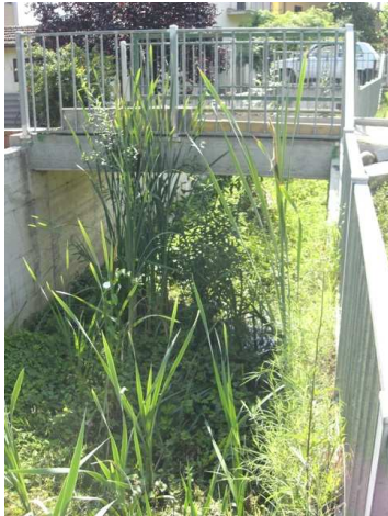
Foto 5.1: vista verso monte, tra le sezioni OR_PS_016 e OR_PS_017. Passerella pedonale.
