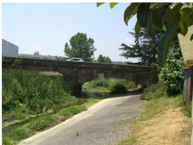
Foto 4.2: vista verso valle, sinistra idraulica, tra le sezioni CA_PS_13.9 e CA_PS_014.1. Note: Ponte sulla S.S. 69 DI VAL D'ARNO.
