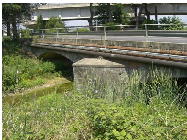
Foto 4.4: vista verso valle, sinistra idraulica, tra le sezioni CA_PS_13.9 e CA_PS_014.1. Note: Ponte sulla S.S. 69 DI VAL D'ARNO.
