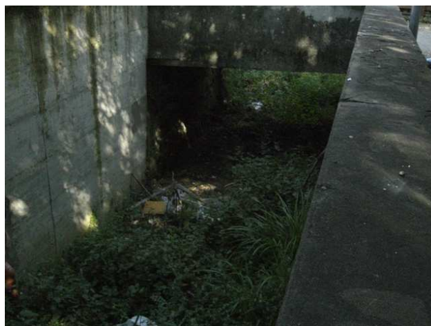
Foto 1.2: vista verso valle, tra le sezioni OR_PS_004 e OR_PS_005.
