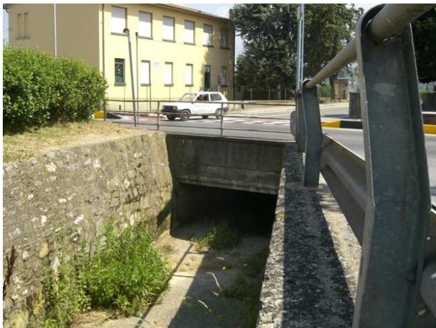
Foto 6.1: vista verso monte, tra le sezioni VL_PS_021 e VL_PS_022. Note: Ponte sulla S.S. 69 DI VAL D'ARNO.
