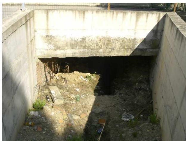
Foto 2.2: vista verso valle, tra le sezioni OR_PS_006 e OR_PS_007. Note: ponte sotto scuola.
