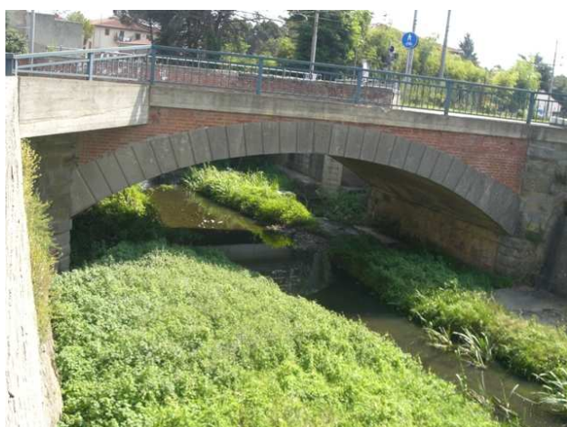
Foto 6.1: vista verso monte, tra le sezioni DO_PS_119 e DO_PS_124. Note: Ponte in VIA DELLE GINESTRE.
