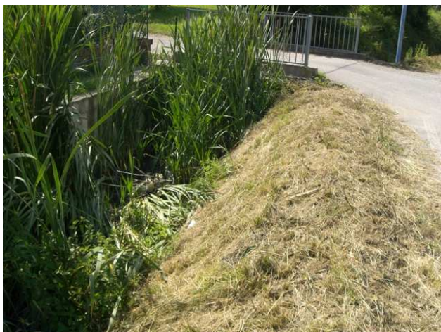
Foto 15.1: vista verso monte, tra le sezioni OR_PS_046 e OR_PS_047.
