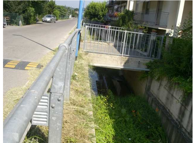
Foto 10.2: vista verso valle, alla sezione OR_PS_029. Passerella pedonale.
