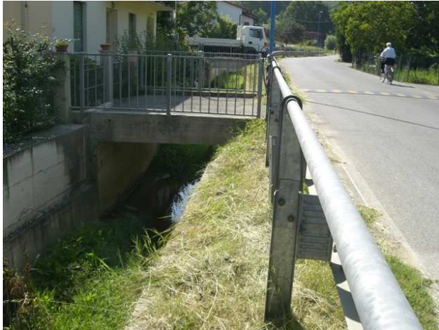
Foto 10.1: vista verso monte, alla sezione OR_PS_029. Passerella pedonale.
