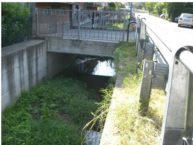
Foto 8.1: vista verso monte, tra le sezioni OR_PS_025 e OR_PS_026. Passerella pedonale.
