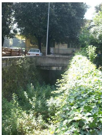
Foto 1.1: vista verso monte, tra le sezioni OR_PS_004 e OR_PS_005.
