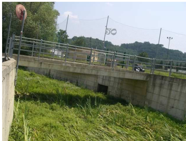
Foto 1.4: vista verso valle, alla sezione SA_PS_012. Note: Passerella pedonale.
