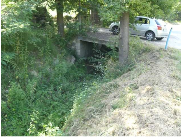
Foto 16.1: vista verso monte, tra le sezioni OR_PS_050 e OR_PS_051.
