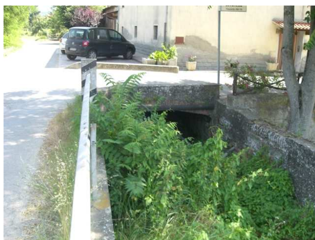
Foto 3.2: vista verso valle, tra le sezioni VL_PS_011 e VL_PS_012.
