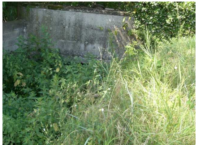
Foto 6.2: vista verso monte, tra le sezioni VL_PS_021 e VL_PS_022. Note: Ponte sulla S.S. 69 DI VAL D'ARNO.
