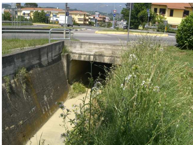
Foto 9.1: vista verso valle, tra le sezioni SP_PS_015 e SP_PS_014. Note: Ponte in VIA DELLA FARNIA.
