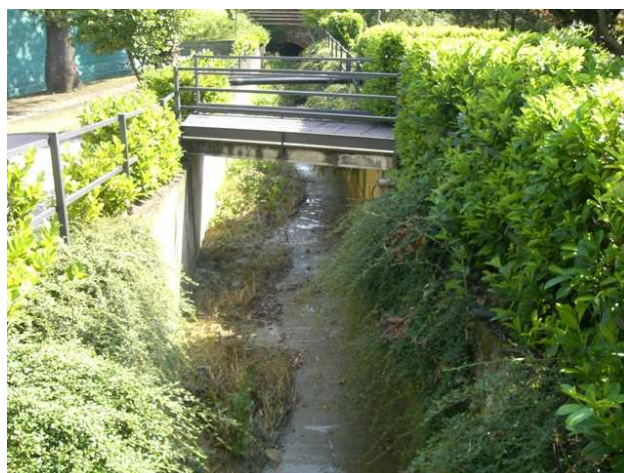
Foto 3.1: vista verso valle, alle sezione SP_PS_042. Note: Passerella pedonale.
