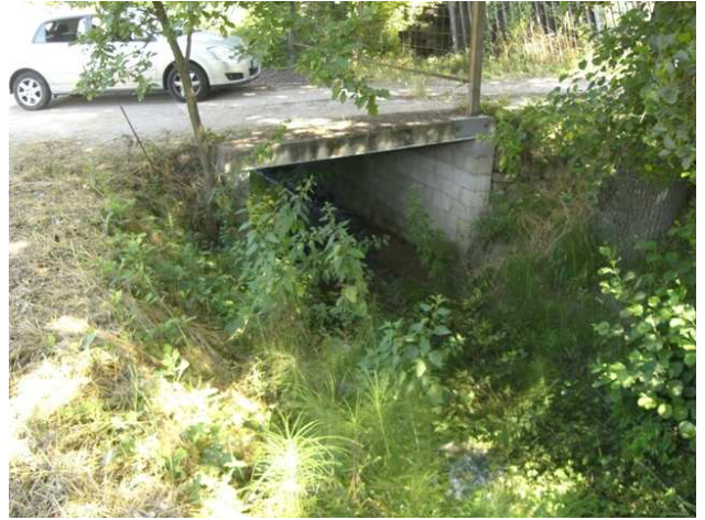
Foto 16.2: vista verso valle, tra le sezioni OR_PS_050 e OR_PS_051.
