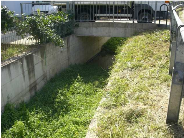
Foto 11.1: vista verso monte, tra le sezioni OR_PS_030 e OR_PS_031. Passerella pedonale.
