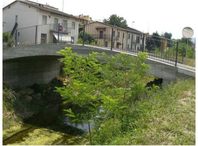
Foto 4.2: vista verso valle, tra le sezioni CA_PS_174 e CA_PS_175.
