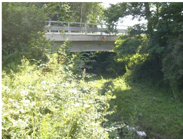
Foto 6.1: vista verso valle, tra le sezioni GI_PS_054 e GI_PS_055. Note: Ponte in VIA DELLA SUGHERELLA.
