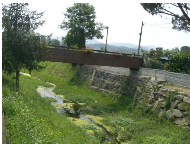
Foto 3.2: vista verso monte, tra le sezioni CA_PS_171 e CA_PS_172. Note: Passerella pedonale.
