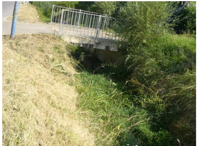
Foto 14.2: vista verso valle, tra le sezioni OR_PS_041 e OR_PS_042.
