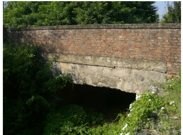
Foto 3.1: vista verso monte, tra le sezioni QU_PS_041 e QU_PS_040. Note: Ponte ferroviario FIRENZE-ROMA
