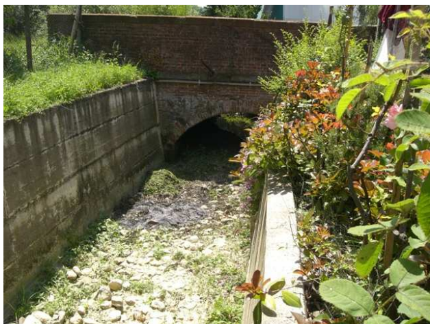
Foto 5.2: vista verso monte, tra le sezioni SP_PS_040 e SP_PS_039. Note: Ponte ferroviario FIRENZE-ROMA.
