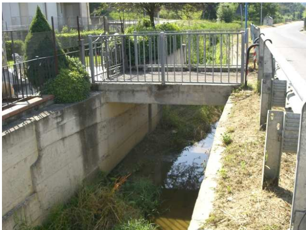
Foto 12.1: vista verso monte, tra le sezioni OR_PS_034 e OR_PS_035. Passerella pedonale.
