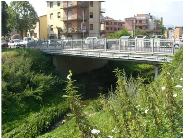
Foto 2.1: vista verso monte, tra le sezioni DO_PS_105 e DO_PS_106. Note: Ponte in VIALE ARMANDO DIAZ.
