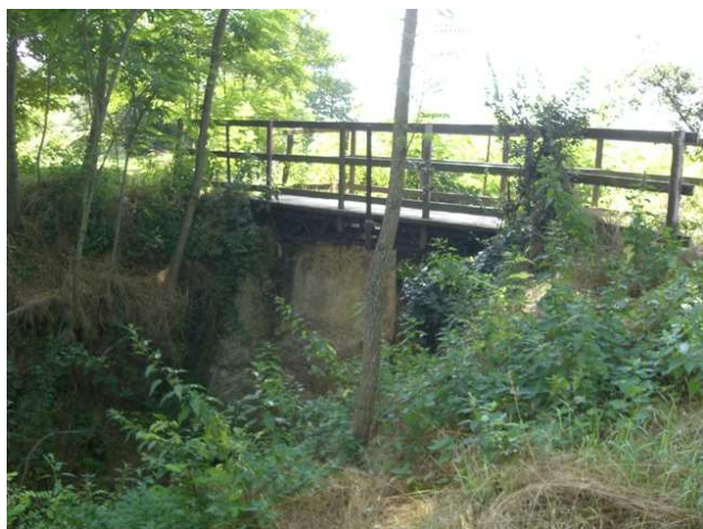
Foto 1.1: vista verso monte, tra le sezioni VL_PS_001 e VL_PS_002. Note: Passerella pedonale.
