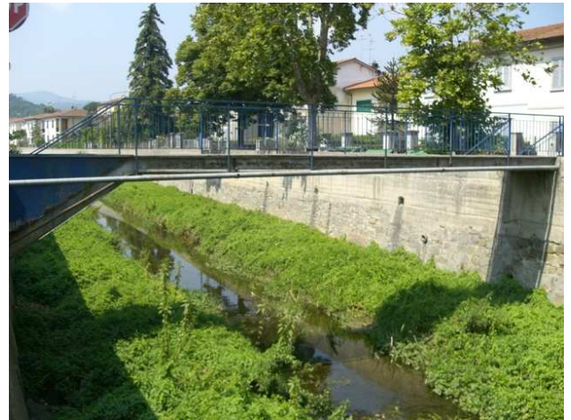
Foto 7.2: vista verso monte, tra le sezioni DO_PS_145 e DO_PS_146. Note: Passerella pedonale.
