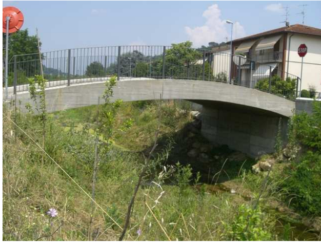
Foto 4.1: vista verso valle, tra le sezioni CA_PS_174 e CA_PS_175.
