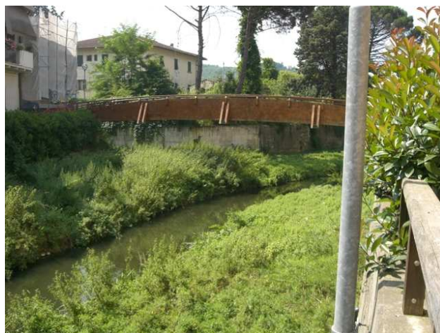
Foto 4.1: vista verso monte, alla sezioni DO_PS_113. Note: Passerella pedonale.
