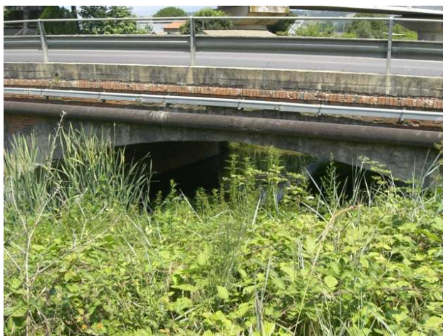
Foto 4.3: vista verso valle, destra idraulica, tra le sezioni CA_PS_13.9 e CA_PS_014.1. Note: Ponte sulla S.S. 69 DI VAL D'ARNO.
