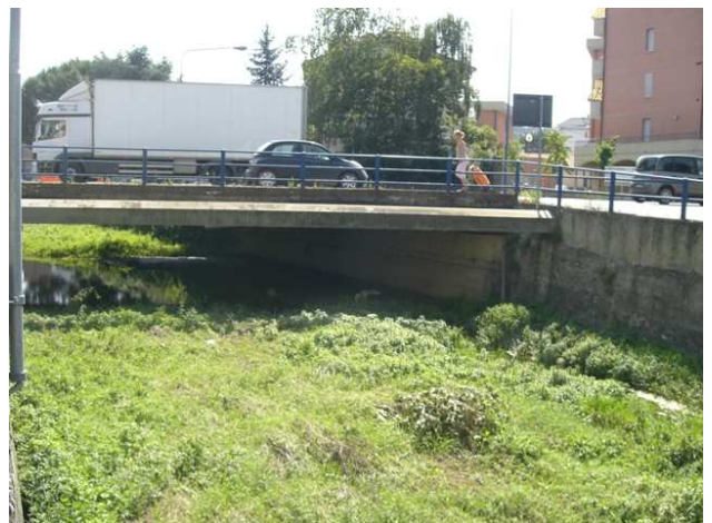
Foto 2.1: vista verso monte, tra le sezioni GI_PS_028 e GI_PS_029. Note: Ponte in VIALE ARMANDO DIAZ.
