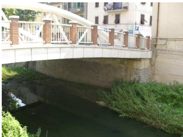
Foto 3.3: vista verso valle, destra idraulica, tra le sezioni DO_PS_112 e DO_PS_111. Note: Ponte in VIA MARCONI.
