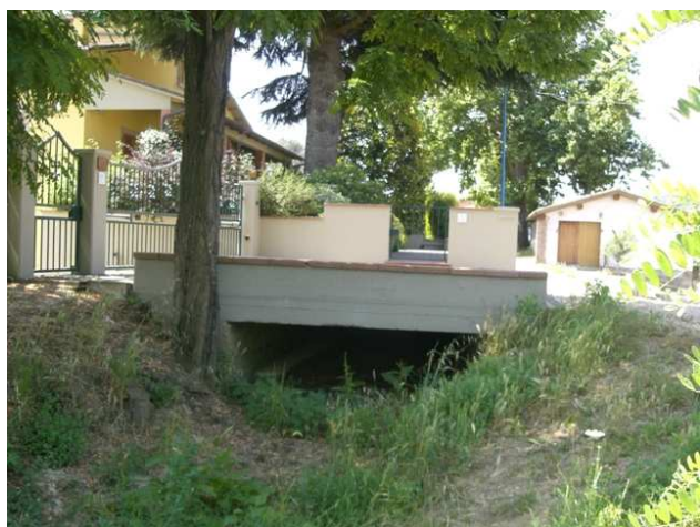
Foto 2.1: vista verso monte, tra le sezioni VL_PS_008 e VL_PS_009. Note: Ponte sotto giardino.
