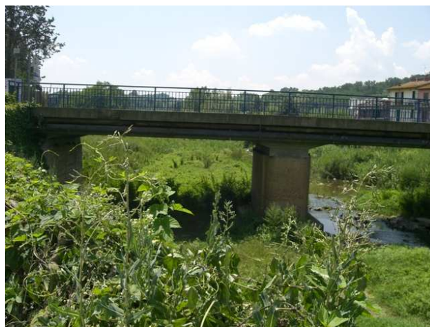
Foto 1.1: vista verso monte, alla sezione AM_PS_046 e la sezione AM_PS_047. Note: Ponte sulla S.S. 69 DI VAL D'ARNO.
