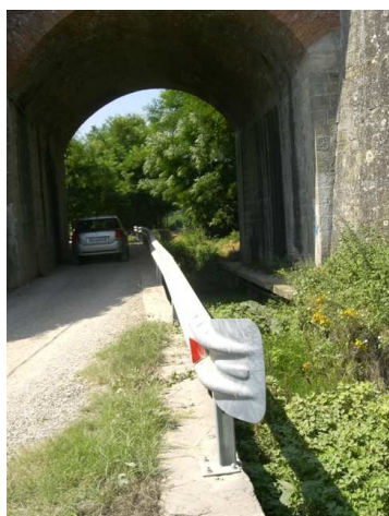
Foto 8.1: vista verso monte, tra le sezioni VL_PS_033 e VL_PS_034. Note: Ponte ferroviario FIRENZE-ROMA.
