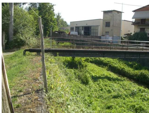
Foto 5.1: vista verso monte, destra idraulica, tra le sezioni GI_PS_044 e GI_PS_045. Note: Passerella pedonale.
