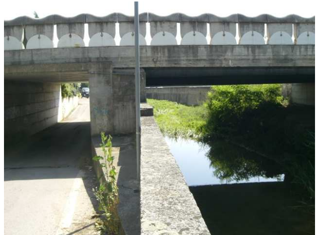
Foto 1.1: vista verso monte, destra idraulica, tra le sezioni GI_PS_013 e GI_PS_012. Note: Nuovo ponte.
