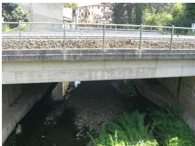
Foto 5.1: vista verso monte, tra le sezioni DO_PS_119 e DO_PS_120. Note: Ponte ferroviario FIRENZE-ROMA.
