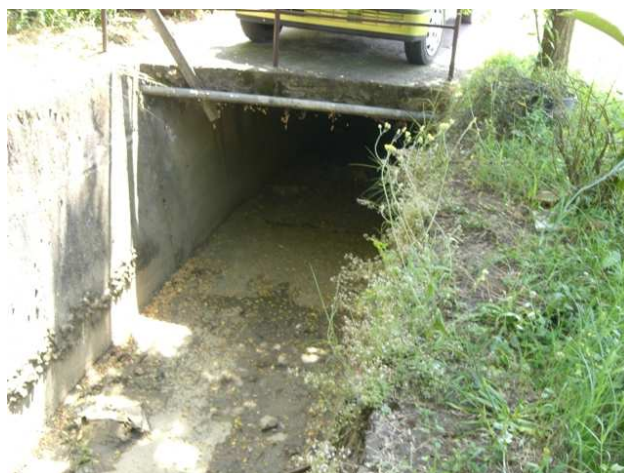
Foto 9.2: vista verso monte, tra le sezioni SP_PS_015 e SP_PS_014. Note: Ponte in VIA DELLA FARNIA.
