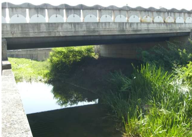
Foto 1.2: vista verso monte, sinistra idraulica, tra le sezioni GI_PS_013 e GI_PS_012. Note: Nuovo ponte.
