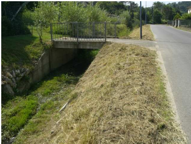
Foto 14.1: vista verso monte, tra le sezioni OR_PS_041 e OR_PS_042.
