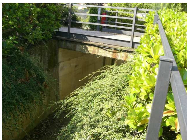
Foto 3.2: vista verso monte, alle sezione SP_PS_042. Note: Passerella pedonale.
