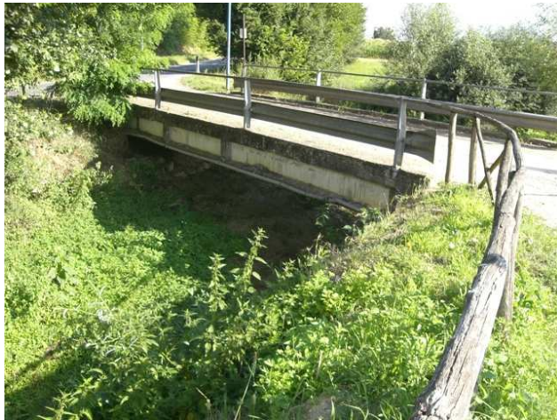
Foto 1.1: vista verso valle, tra le sezioni QU_PS_059 e QU_PS_060.
